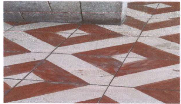
FOTO 4: Sustitucion de piso de torta de concreto (cocina)
